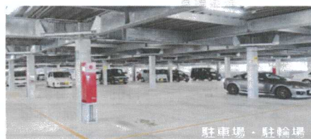
駐車場・駐輪場
